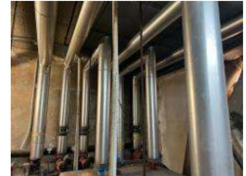
Installation für die Wärmerückgewinnung aus der Kühlungsanlage zur Nutzung für die Klimaanlage im THB Guya Playa.
