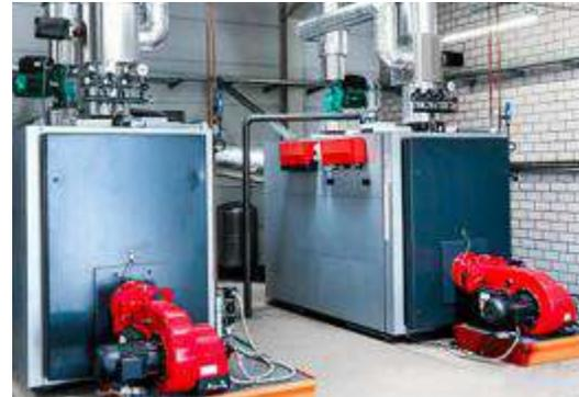
Austausch der Ölheizkessel durch effizientere Gasbrennwertkessel.
